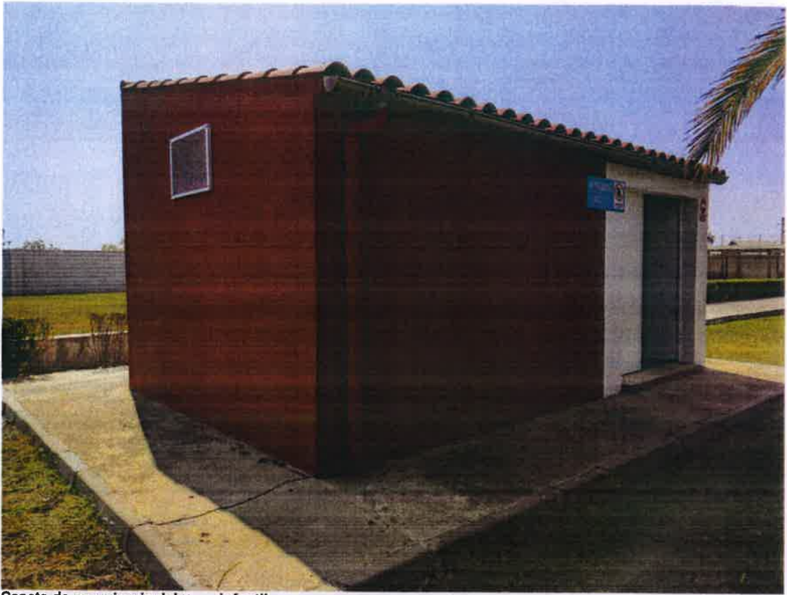
Caseta de maquinaria del vaso infantil
